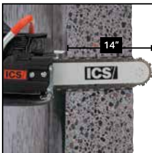
Corte profundo para abrir aberturas obstruidas o estrechas
